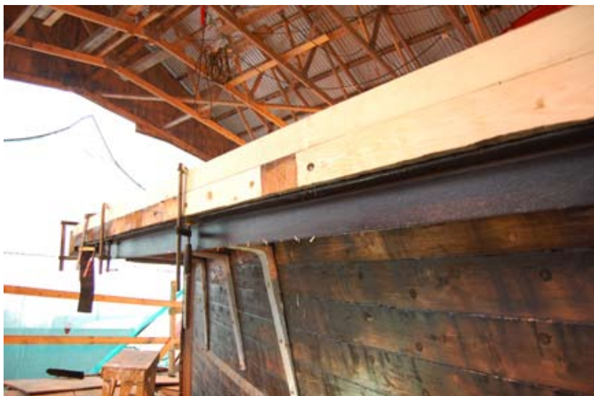
Et kraftig vinkeljern boltes i hangarsjegg.
