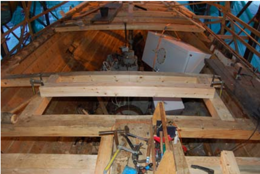
En stikkbjelke skal felles inn mellom de to kravellene.
