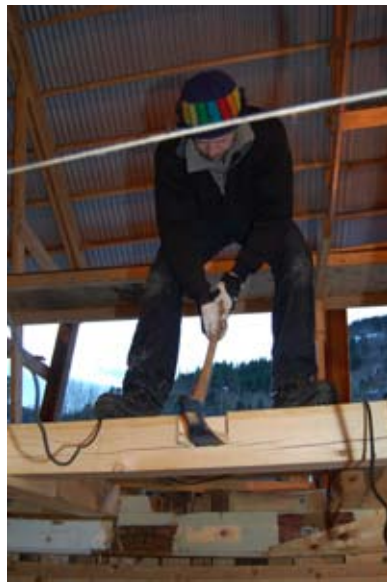
Hakket for stikkbjelken lages med stikk-sag, skarøks og stemjern.
