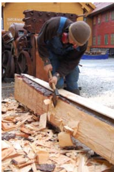
Ivar Hofflandsdal grovhugger sidekjølsvinet før det heises ombord. Sidekjølsvinet ligger ved siden av maskin-fundamentet. Det er bare STB-sidekjøl-svin som skiftes; det andre er i rimelig bra forfatning.
